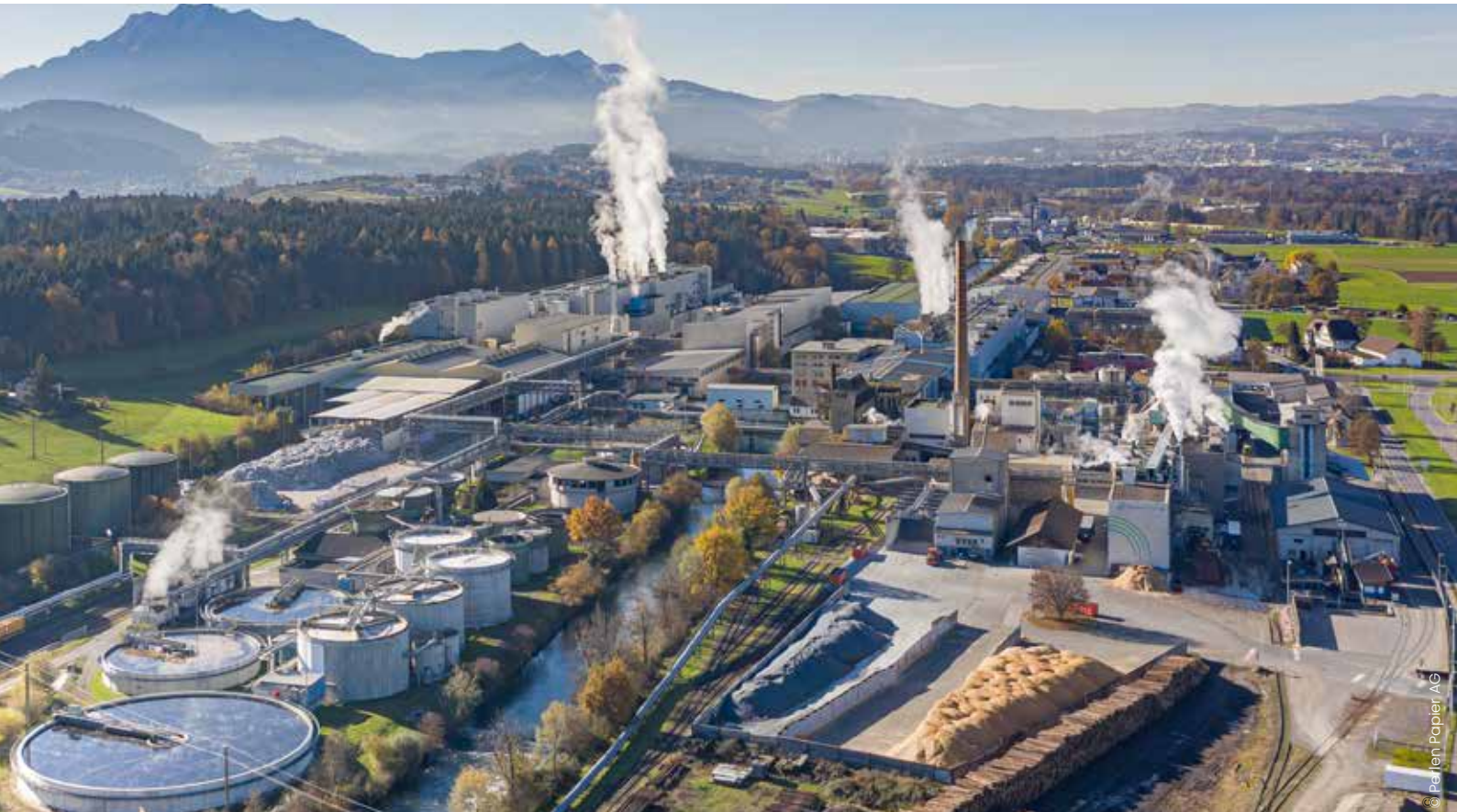
Perlen Papier AG - Luftaufnahme Werk in Perlen CH
